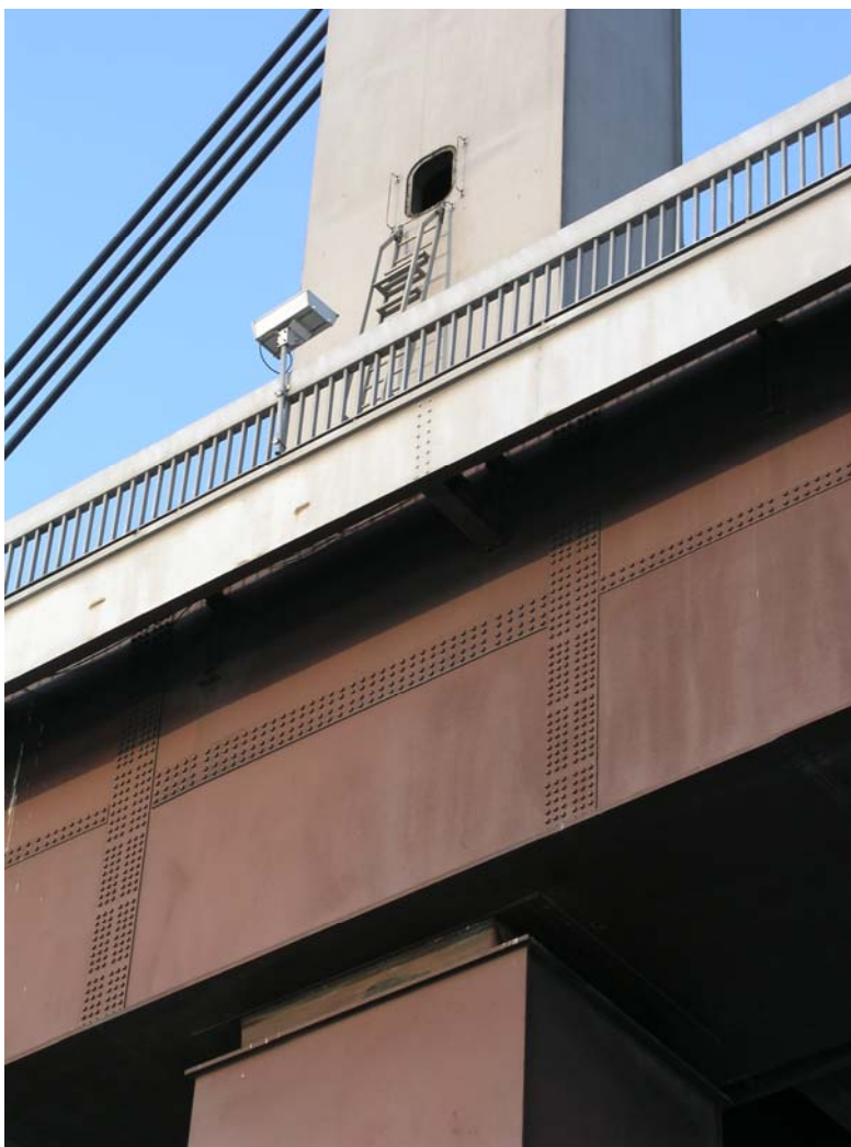
„Нови“ железнички мост преко реке Саве - Београд
