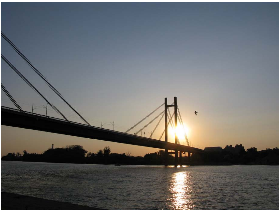
„Нови“ железнички мост преко реке Саве - Београд
