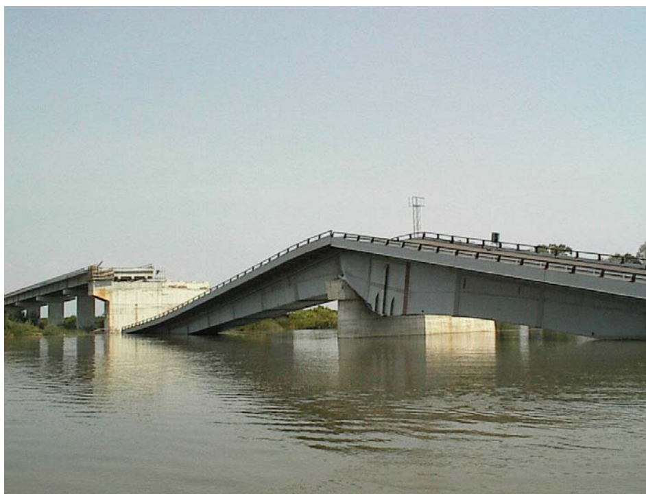
Срушена конструкција моста преко реке Саве – Београд
