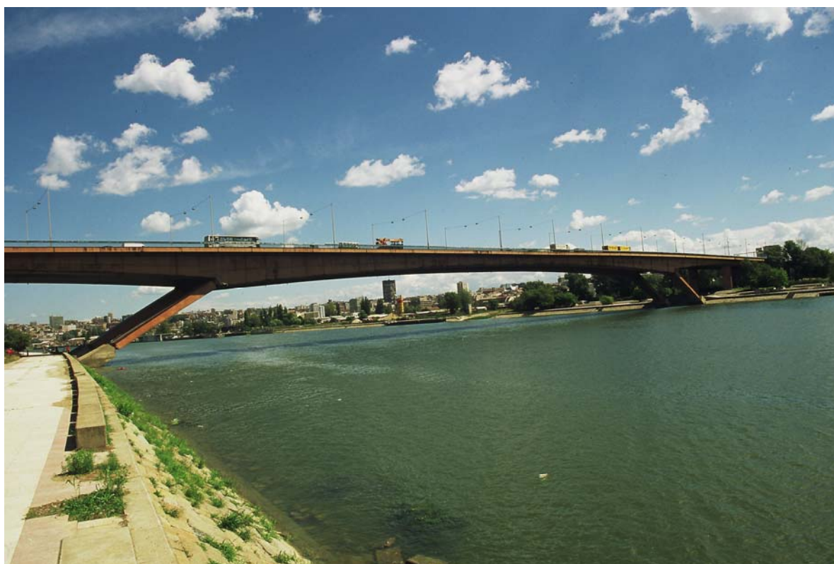
Мост „Газела“, Београд – Србија
