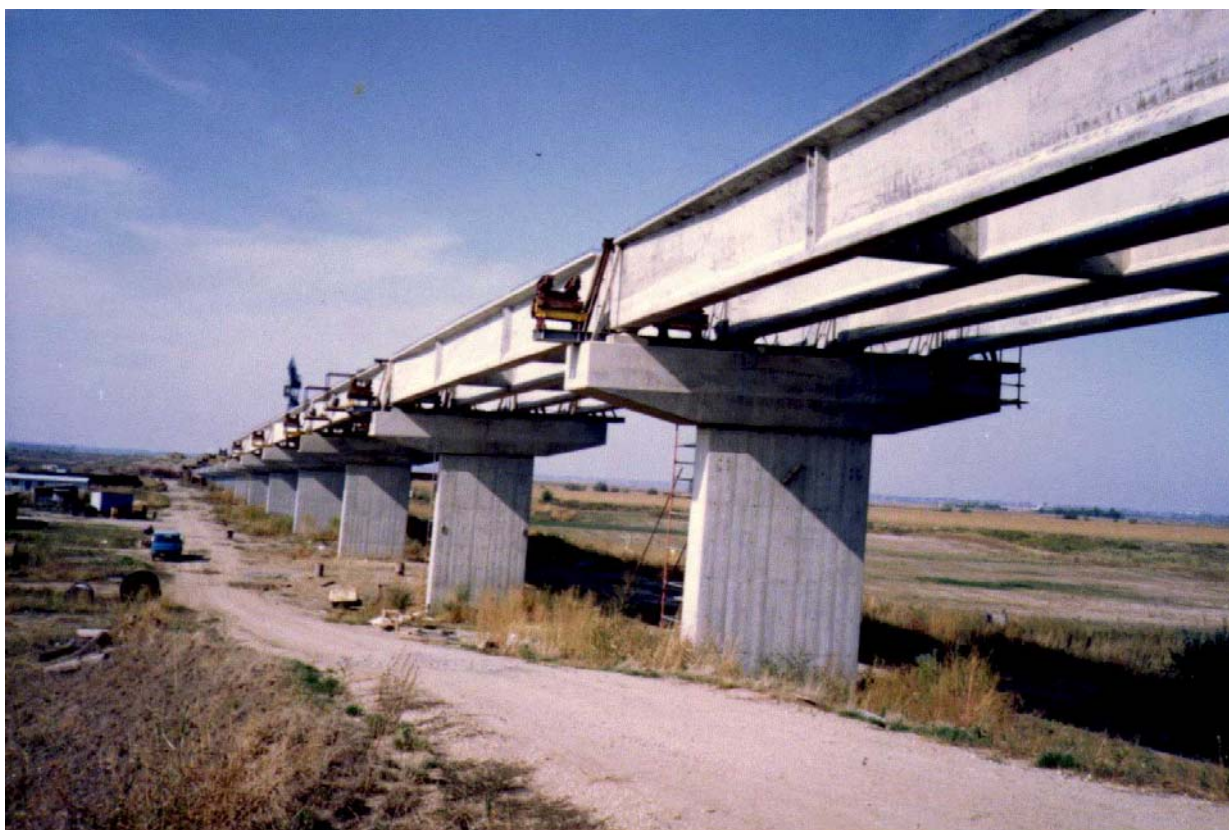
Прилазне конструкције мосту преко реке Саве код Остружнице - Београд
