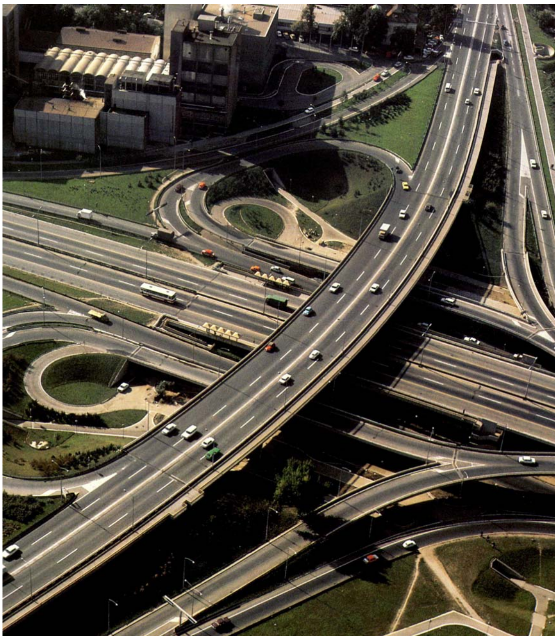
Мостарска петља и прилазне конструкције мосту „Газела“ - Београд
